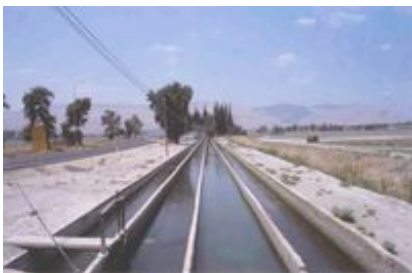
Abb. 5 Zum heutigen Bewässerungssystem in der Bucht von Bet-Schean gehören Kanäle, die Wasser mit unterschiedlichem Salzgehalt führen.
