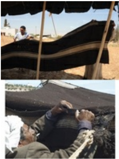
Abb. 5 a) Anbringen der Seitenbahnen (arab. rwāq ). b) Befestigen der Seitenbahnen mit Holzstiften (arab. hille ).
